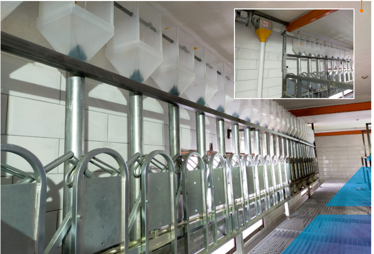
Sistema de reparto automático desde un silo de pienso a los comederos de la cuadra.
